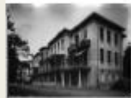
1911 - Foto dell'edificio di Via Salaria 100
