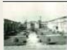
1911 - Foto dell'edificio di Via Salaria 100
