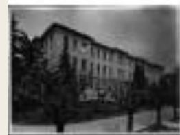
1911 - Foto dell'edificio di Via Salaria 100
