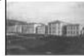
1911 - Foto dell'edificio di Via Salaria 100
