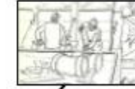
8 REALIZZAZIONE TRONCO FOGNARIO
