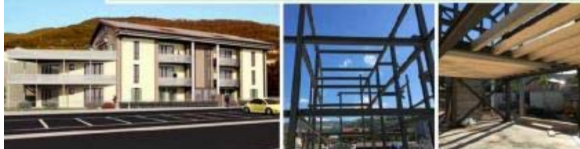
Cantiere Grezzana (VR): struttura portante in acciaio, muratura di tamponamento realizzata con 32 cm di Natural Beton® 200 posati con pompa e proiezione su parete in laterizio da 8 cm. Trasmissione: 0,153 W/(m²K). Sfasamento Termico: 19h 30'.
