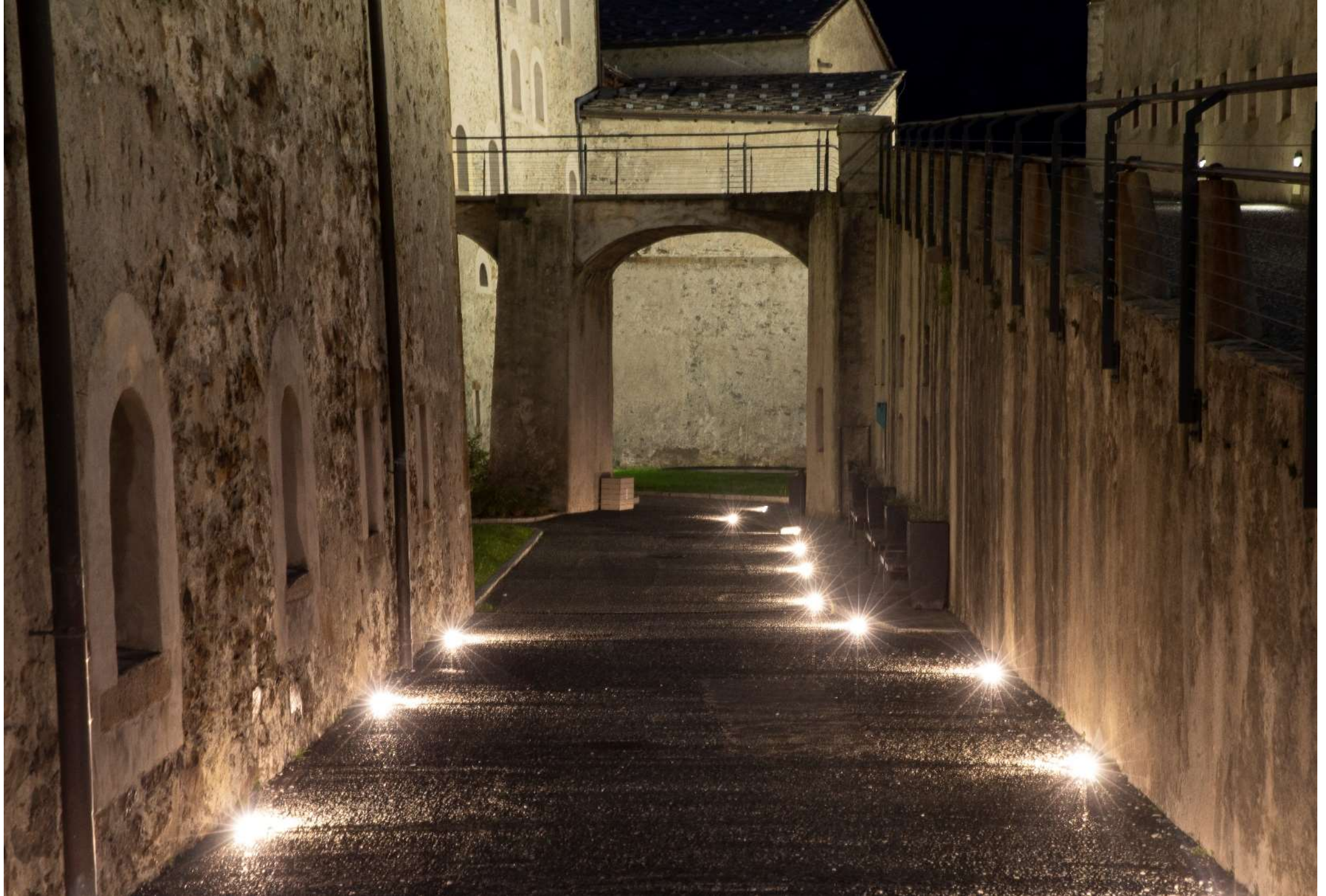
FORTE DI BARD – BARD (AO) - GOCCIA ILLUMINAZIONE
