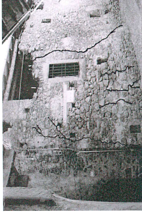
Edificio in Valtellina. Traslazione verticale intermedia presumibilmente a causa di cedimenti differenziali del terreno di fondazione. (Folli E., 2000/2001)
